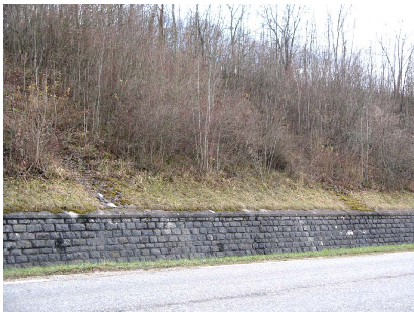
Eloise-OG2 : RN508, au niveau de l'autoroute A40 – Mur de confortement en pierres maçonnées.
