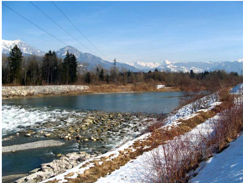
Vougy-OT1 : Rivière de l'Arve au pont de la Sablière – Seuil en travers et enrochements en rive gauche (avec risberme intermédiaire).
