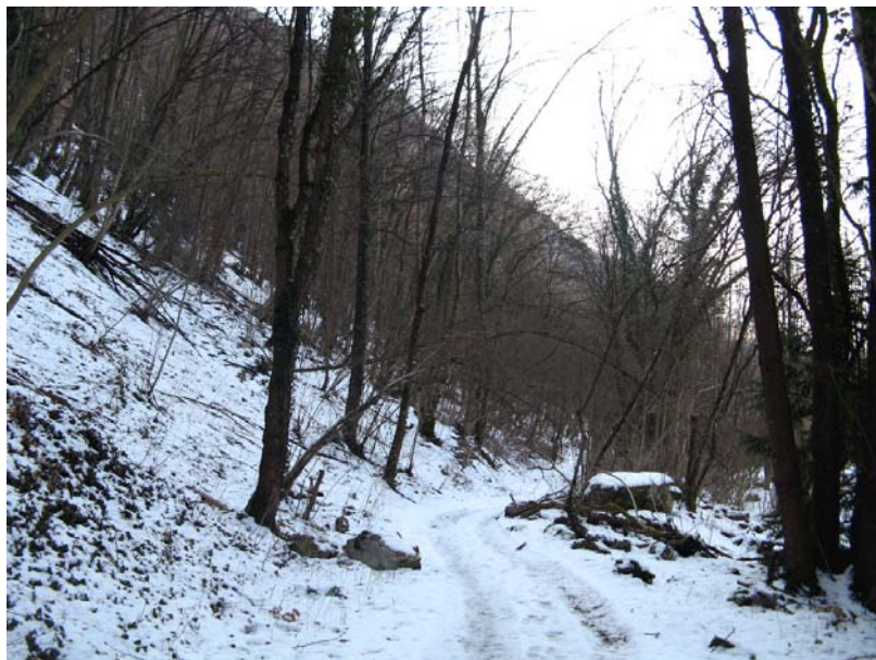
Vougy-EP2 : Sous le Rocher Noir – Pierres et blocs isolés issus de chutes de pierres stoppées au niveau du chemin.
