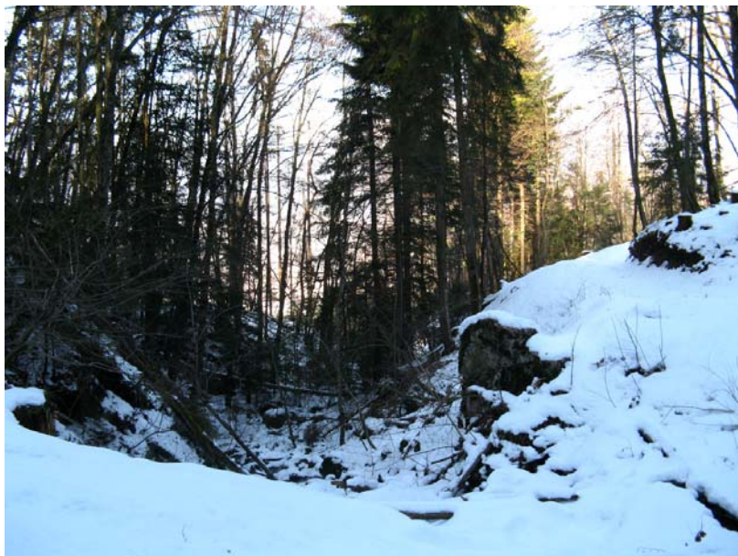
Vougy-EGT1 : Nant de Béguet , vers 600 m d'altitude – Accumulation de branchages et affouillement de berges dans le thalweg.
