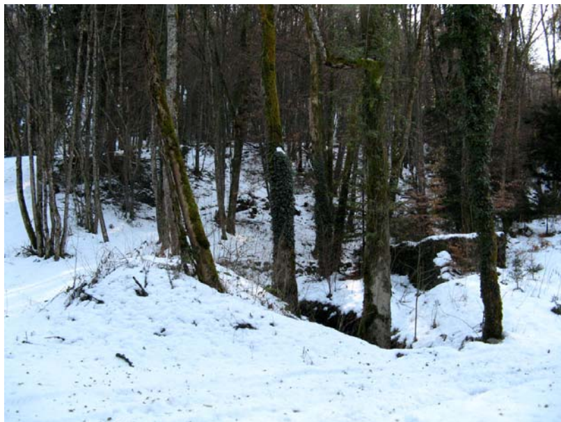
Vougy-OT2 : Nant du Cé, au dessus du cimetière – Protections sur les berges en amont du cône de déjection (digue en terre, murs en pierres).
