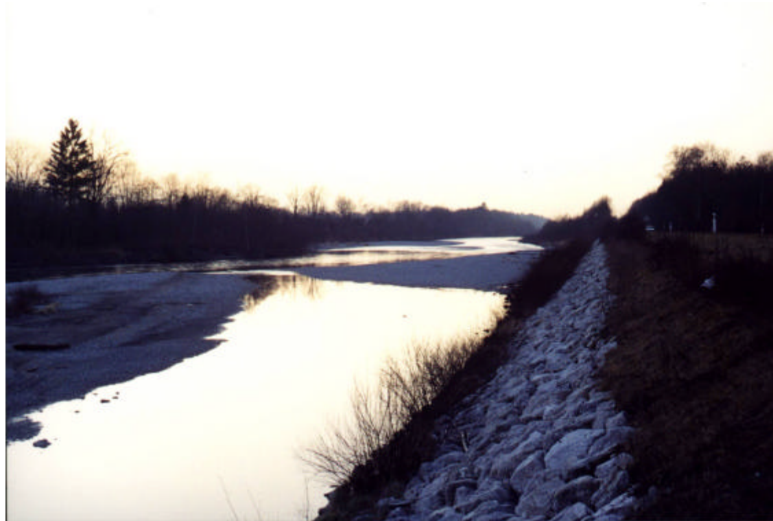
Photo 6 : L'Arve en amont de Bonneville (Cliché RTM – 12 / 01 / 2000)
