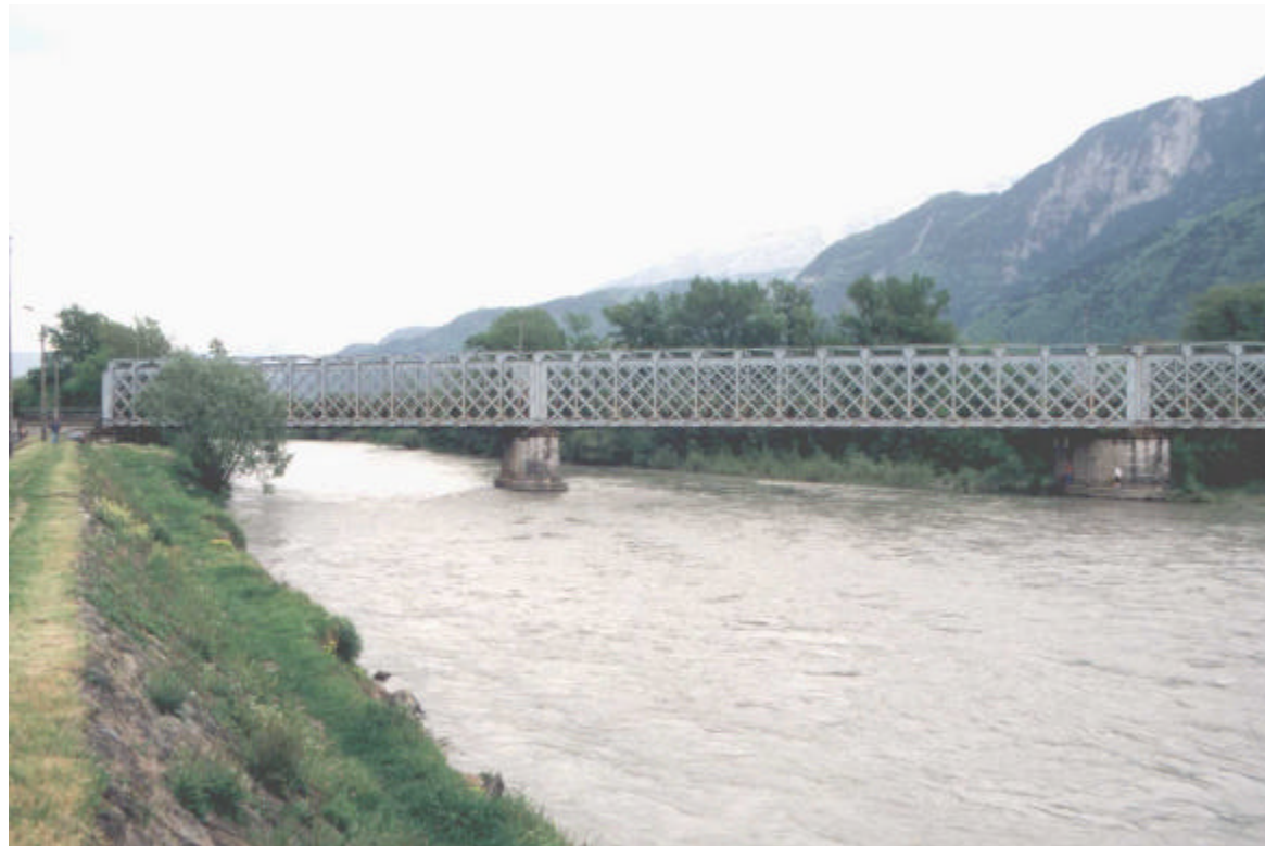
Photo 7 : Pont SNCF à Bonneville (Cliché RTM – 07/05/1999)
