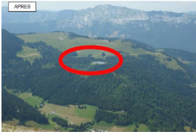
Source Abest, 2018 - EE page 144. Insertion paysagère depuis le sommet du télésiège de l'Etale
