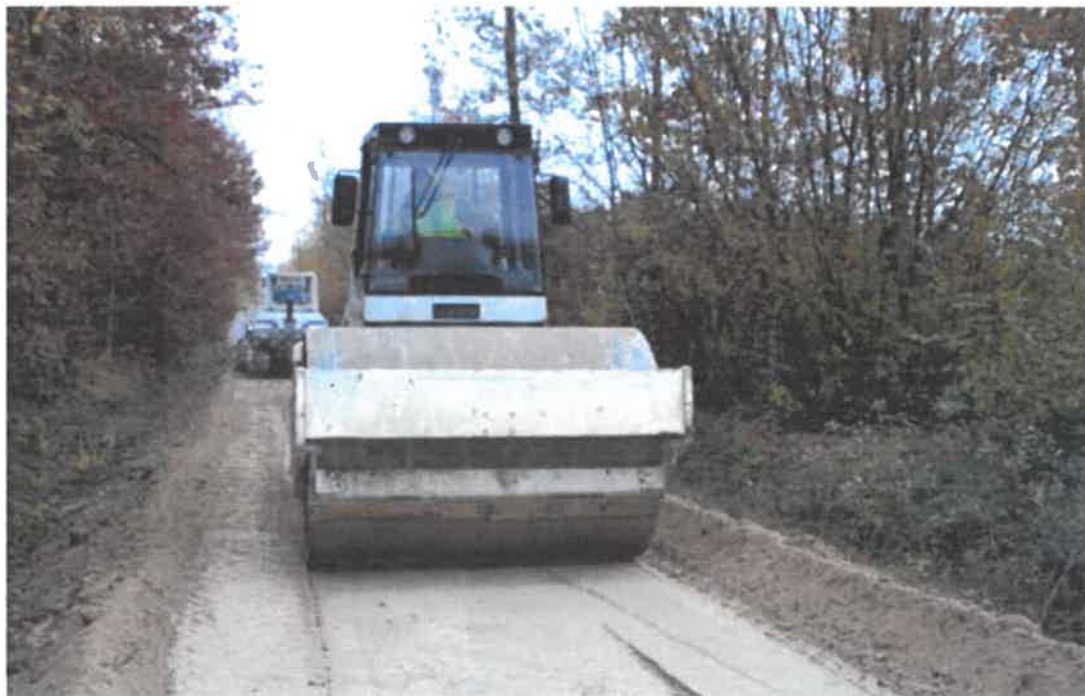
Compacteur en forêt domaniale de Villefermeoy (77), route forestière du Petit Étang
