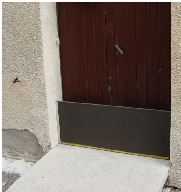
Figure 4: Exemple de batardeau.
