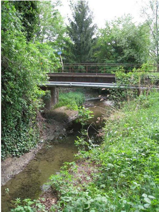
La voie ferrée actuelle franchit le Foron.
