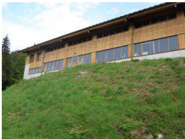
Vue de la société depuis le chemin vicinal longeant la menuiserie
