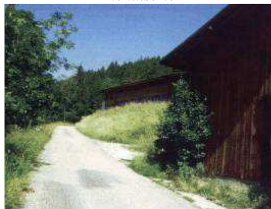
Vue, le long de la route menant au Bois Berger : au 1er plan, du hangar, contenant le bas de traitement, au second plan, l'atelier de travail du bois.
