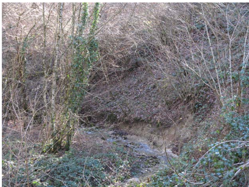
Clermont-EGT1 : Ruisseau de Vorcier, en limite de commune – Affouillement de berges et glissements en pied de versant.
