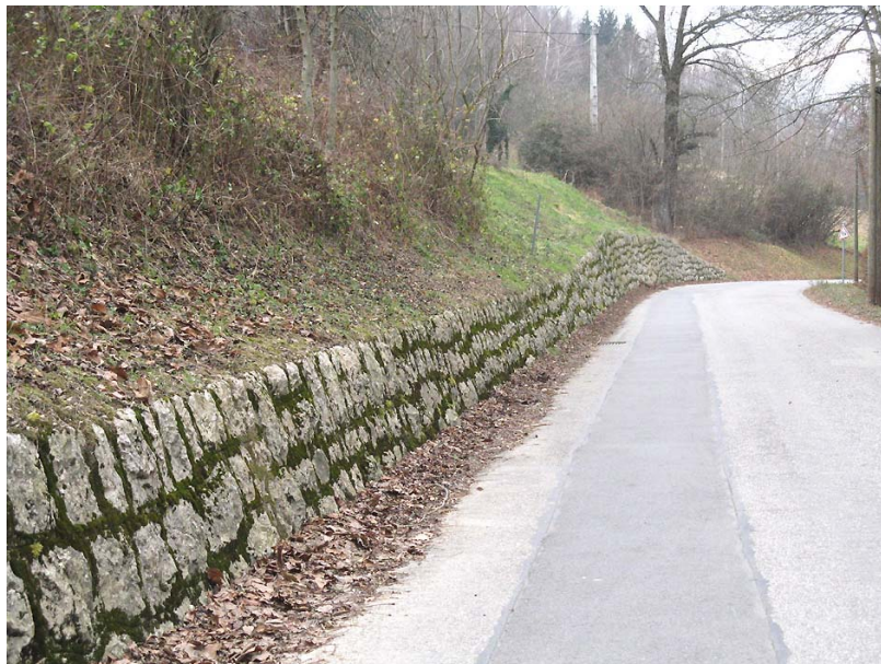
Dingy-OG1 : Les Morennes, route menant à Jurens – Mur de pierres maçonnées confortant la base du talus.
