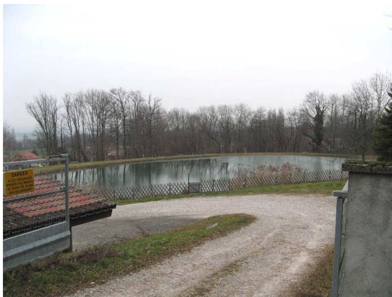
Dingy-OH1 : Bloux, en dessous de la route menant à Jurens – Retenue artificielle.
