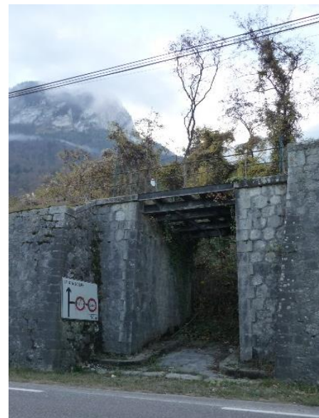
Figure 120 : Pont permettant l'acheminement des matériaux sous la voie ferrée – Source : KARUM
