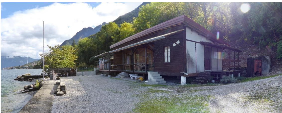
Figure 74 : Bâtiments à démolir sur les berges du lac Léman dans le cadre du projet
