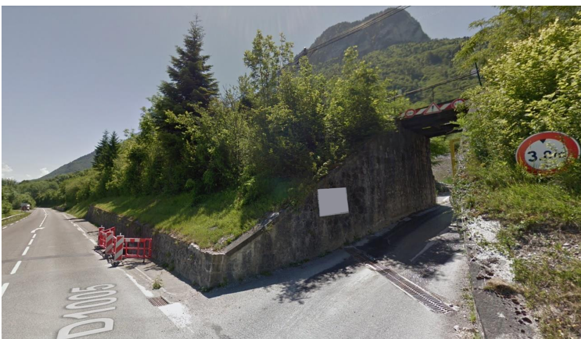
Figure 14 : Vue de l'entrée de la carrière depuis la RD 1005 – Source : Google Street View
