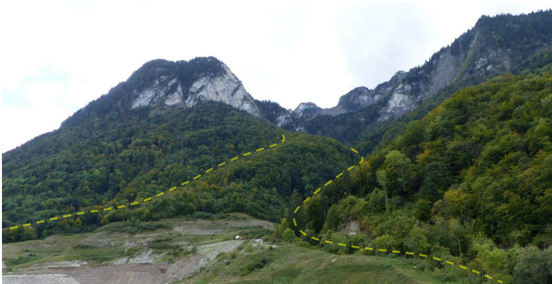
Figure 22 : Vue sur les ravins des torrents de la Chéniaz (à droite de l'image) et des Morges (à gauche) délimitant le site de projet de la carrière respectivement côtés ouest et est – Source : KARUM
