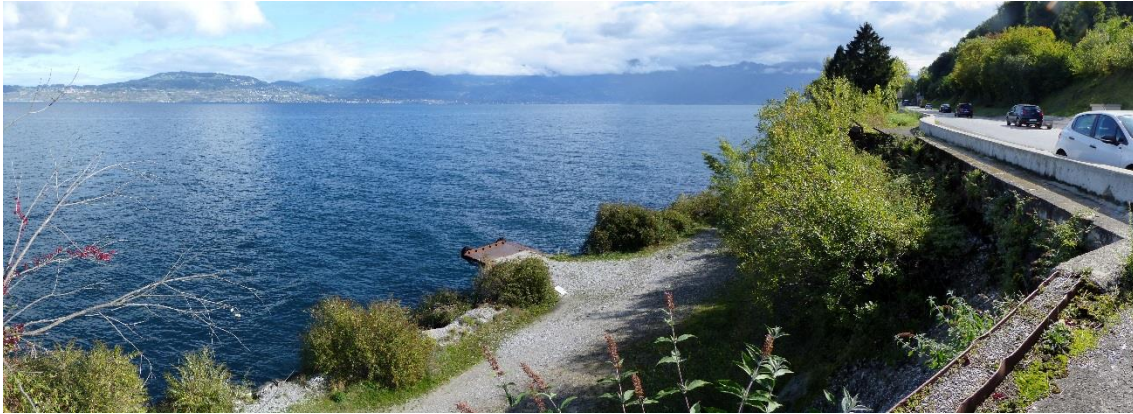
Figure 16 : Perception du ponton du Locum existant depuis l'aire de stationnement le long de la RD 1005 – Source : KARUM
