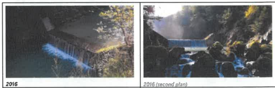
Vues de l'ouvrage OU_17 (ROE23376)
