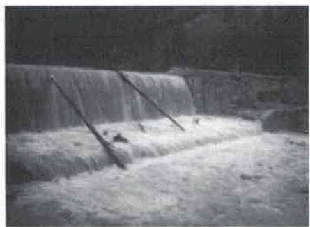
1937 contre-barrage initial repris ensuite par l'ouvrage de 1978
