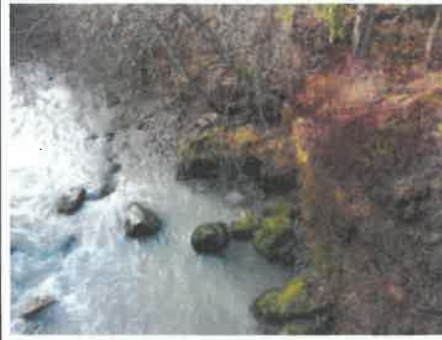
2016 épi en pied du pont RD 22
