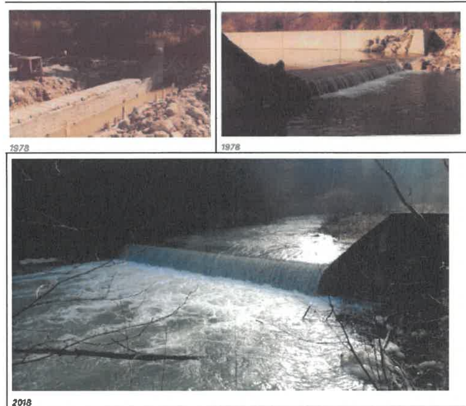
Vues de l'ouvrage OU_25 (ROE23369)
