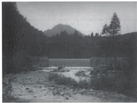
1936 barrage-seuil et contre-barrage initial (ouvrage repris depuis) de MARPHOZ, les ailes ont été relevées plus tard.
