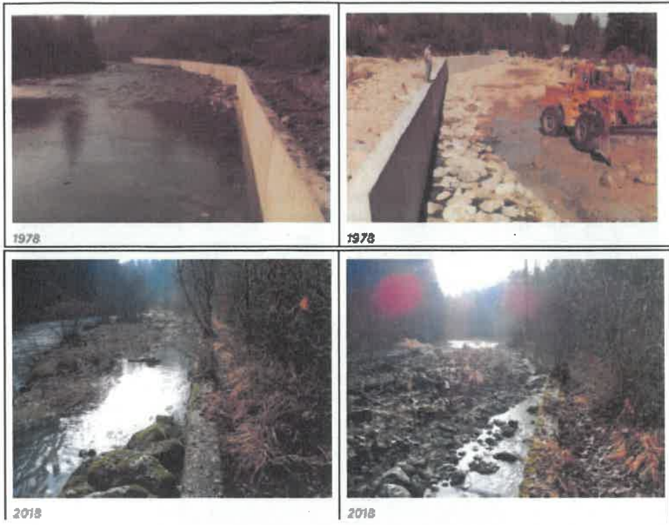
Vues de l'ouvrage OU_26
