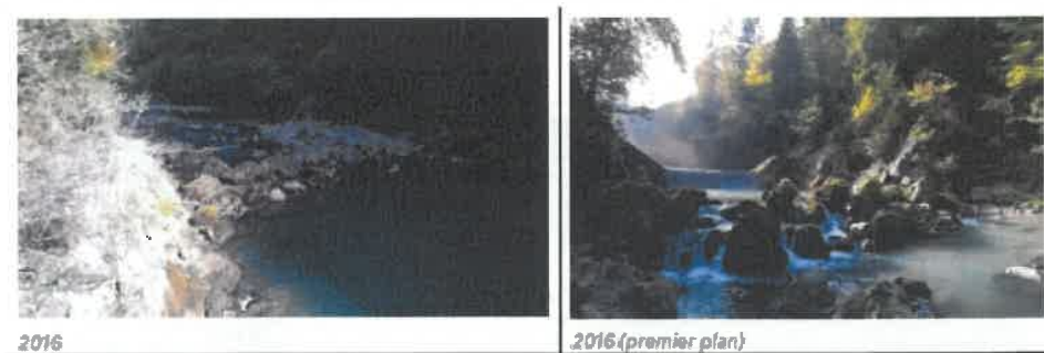
Vues de l'ouvrage OU_18 (ROE23375)
