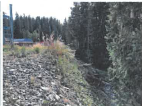
Vue du talus enroché depuis les abords de la gare de départ du TS de Séraussais
