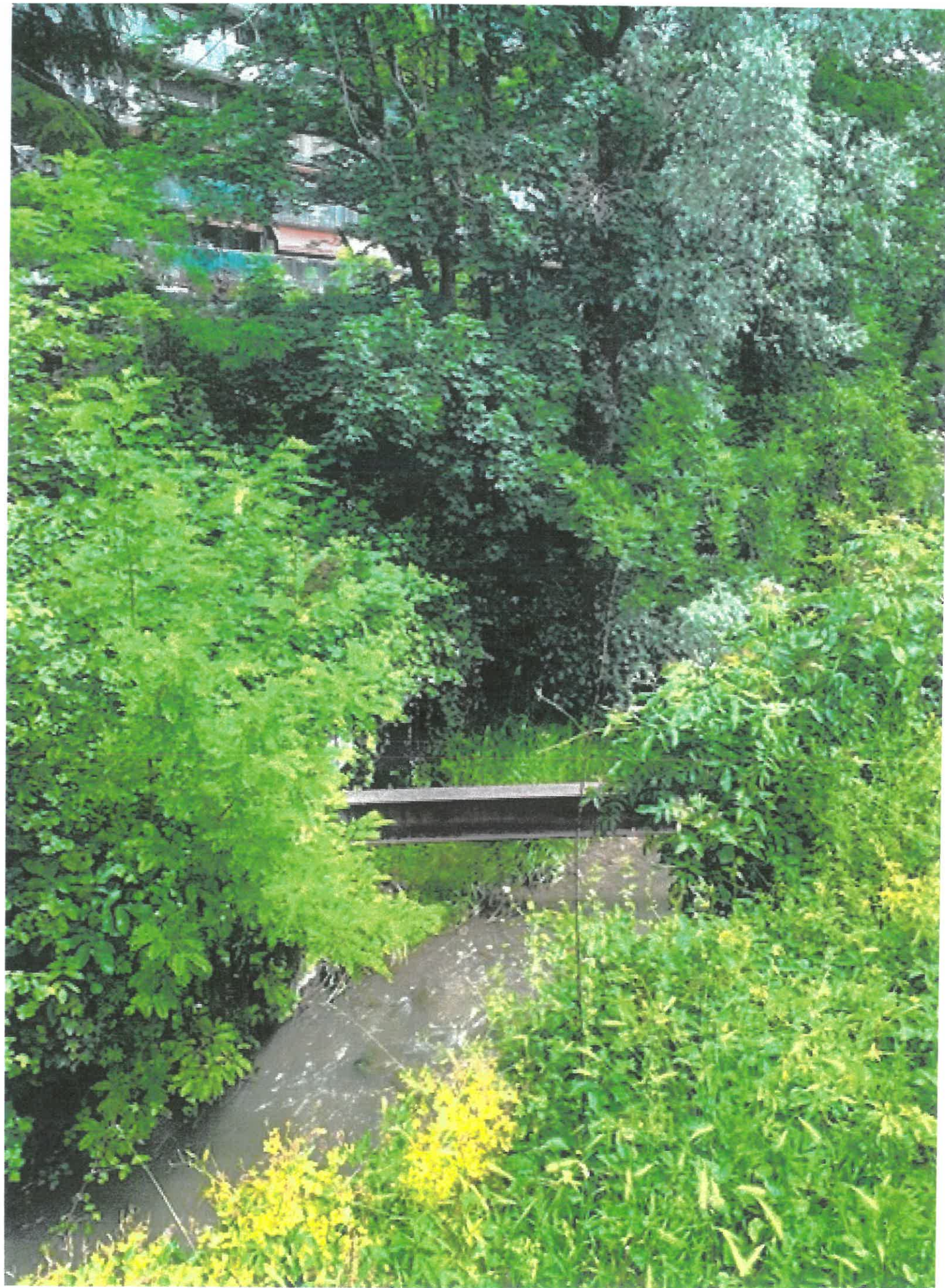
BUSE GAILLARD Ports de France .
