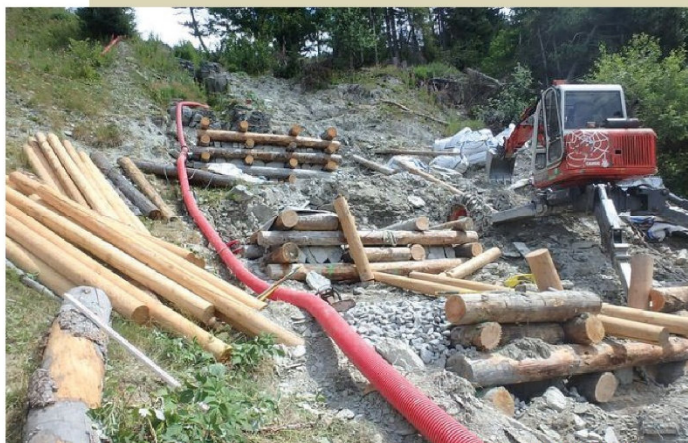
Travaux en forêt domaniale RTM du Pas du Roc - RTM 73
