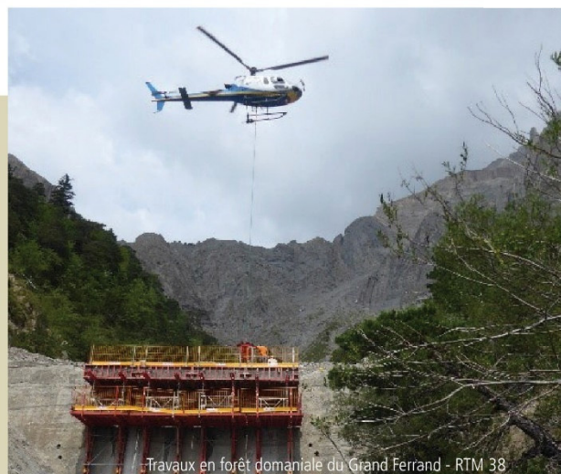
Travaux en forêt domaniale du Grand Ferrand - RTM 38
