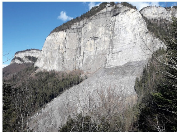
Eroulement rocheux à Sallanches - Haute-Savoie - 2020
