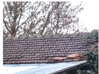
tuiles à remplacer
