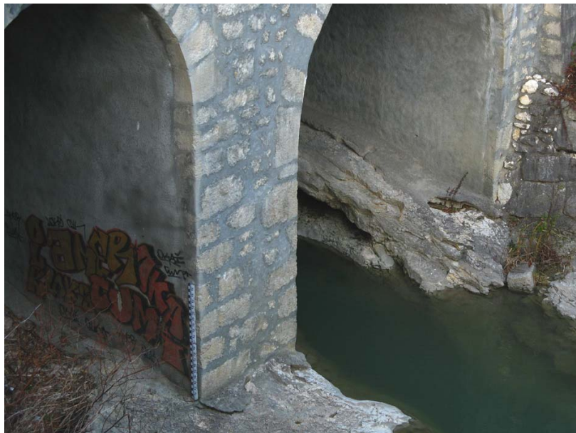
Chilly-OT1 : Rivière des Usses au pont des Douattes (RN508) – Echelle limnimétrique en aval du pont.
