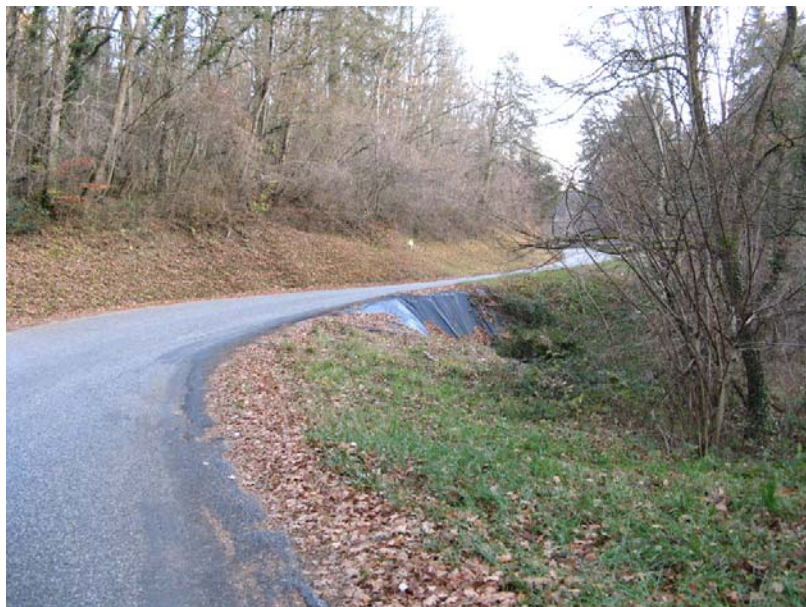
Chilly-EG2 : RD197, au Bois Bugnin – Glissements aux abords de la chaussée.
