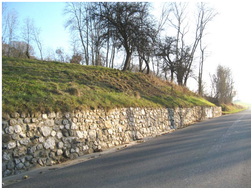
Chilly-OG1 : RD17, entre Mougny et Bornachon – Mur de pierres maçonnées confortant le talus.
