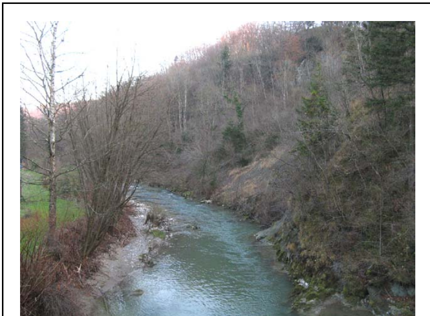
Chilly-EGT1 : Rivière des Usses, au pont de Serrasson – Erosion de berges et glissements de terrain en rive gauche.
