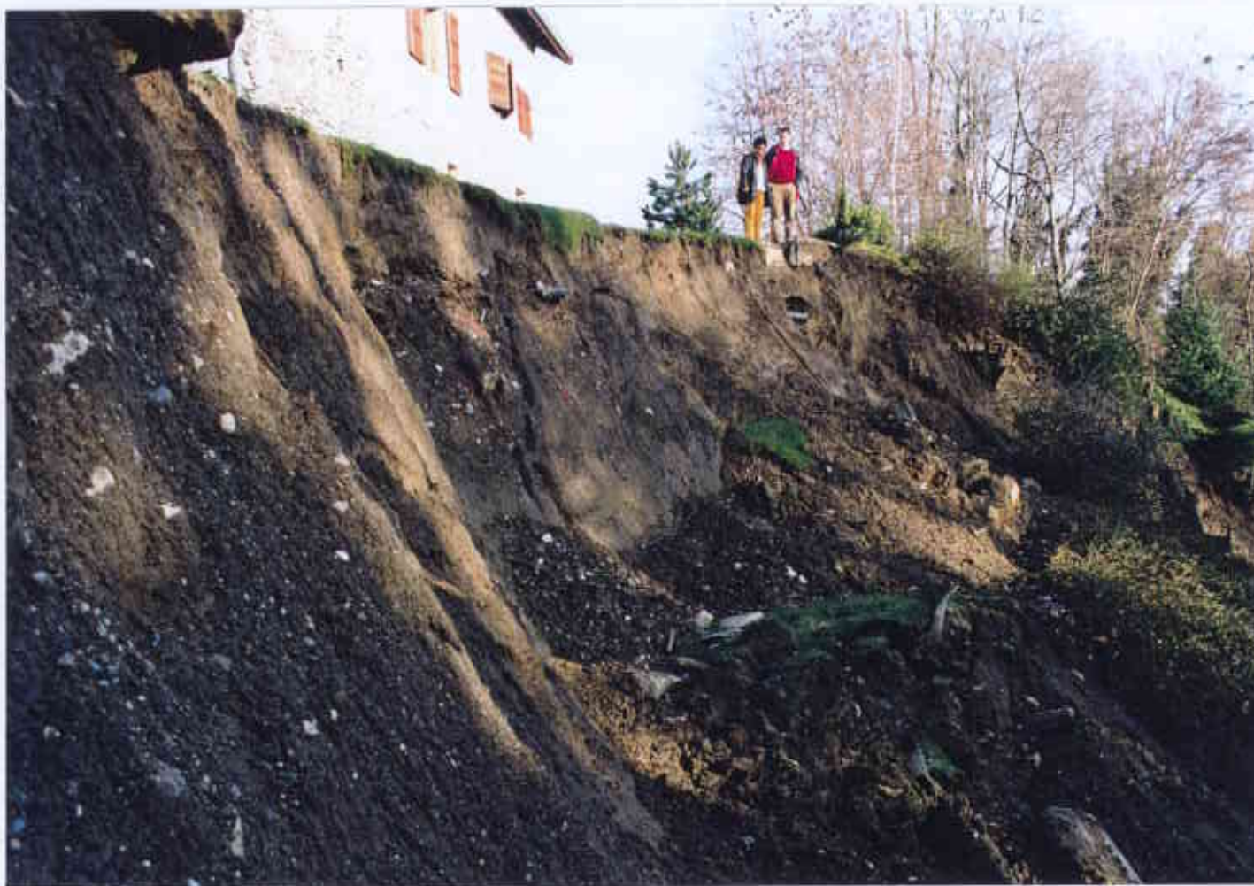
Glissement de terrain ayant emporté la terrasse d'une habitation, au hameau de Marigny.
