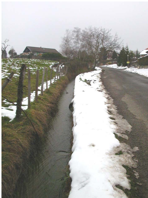
Loisin-OT1 : RD1206 à Tholomaz – Canalisation des écoulements du ruisseau qui descend de la Canne.
