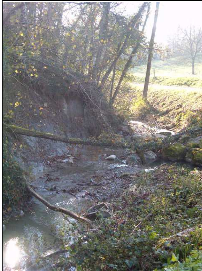
Affouillement des berges du ruisseau de la Folle, au niveau du Moulin Desborne
