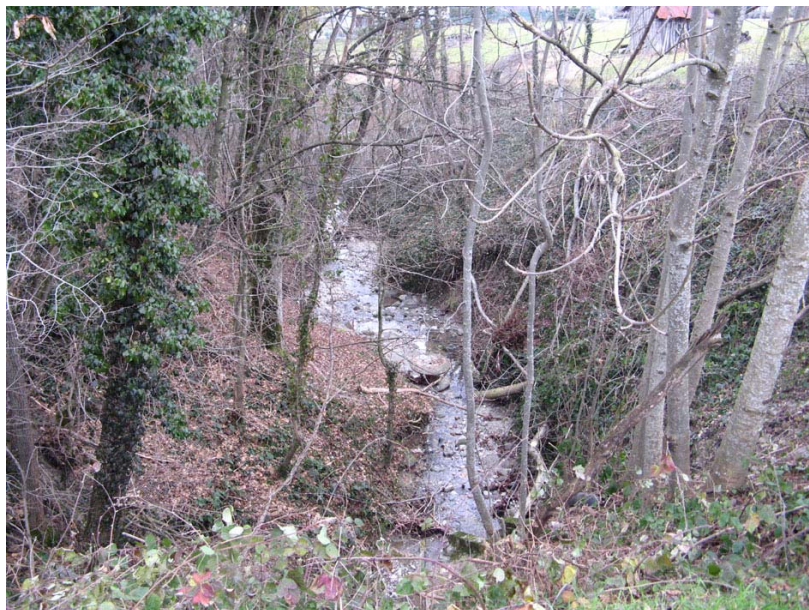
Valleiry-ETG1 : Nant de Vosogne, en aval de la voie ferrée – Loupes de glissements en rive droite.
