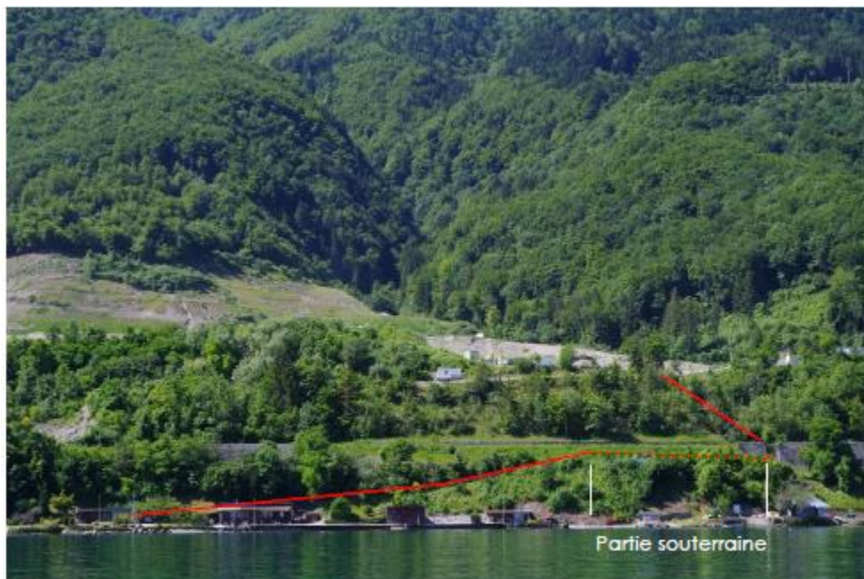
Figure 29 : tracé approximatif du tapis (trait rouge) jusqu'au quai de chargement – Source : Karum
