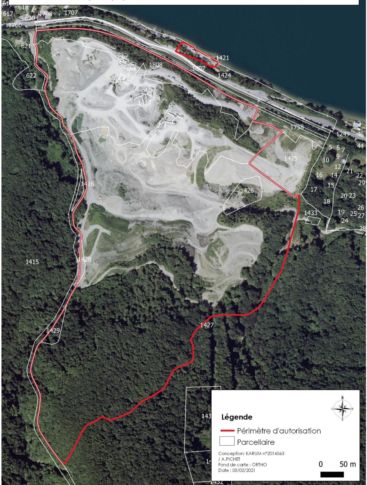
Figure 9 : parcellaire concerné par le projet secteur carrière avec quai de chargement – Source : Karum
