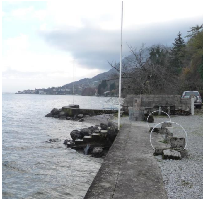
Figure 28 : quai de chargement des matériaux à expédier – Source : Karum
