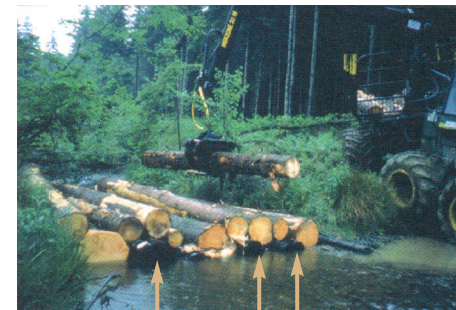
Dépôt d'un billon sur tuyaux PEHD
