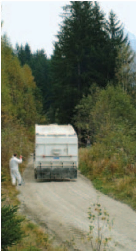
L'épandage du liant hydraulique routier s'effectue sur une largeur de 3 mètres.
