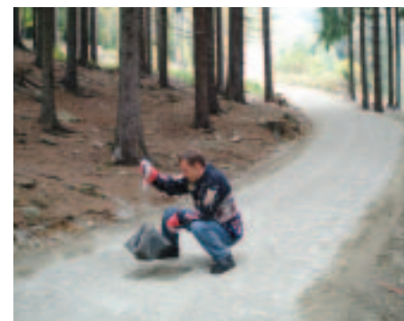
La quantité de liant déversée peut être vérifiée par simple pesée.
