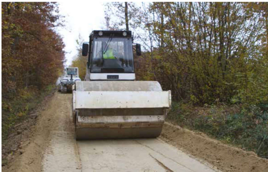
Compacteur en forêt domaniale de Villefermoy (77), route forestière du Petit Étang
