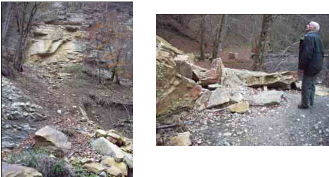
Figure 13 : Photos de l'éboulement de la route d'accès aux sources thermales.
