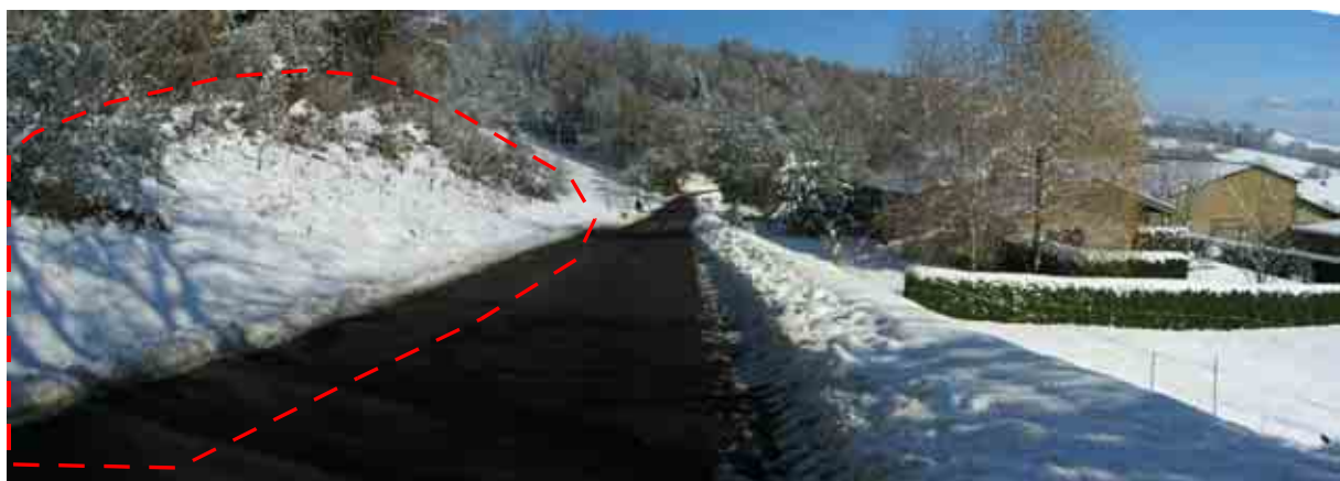
Figure 15 : Vue sur le mur de soutènement du Glissement du Suet.
