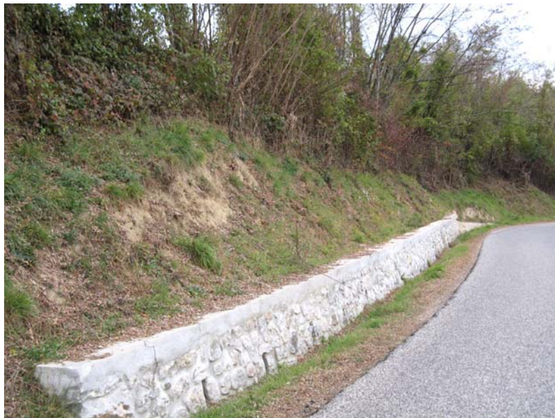
StEusebe-OG1 : RD38, entre le ravin de la Chaudière et Thusel – Mur en pierres maçonnées.
