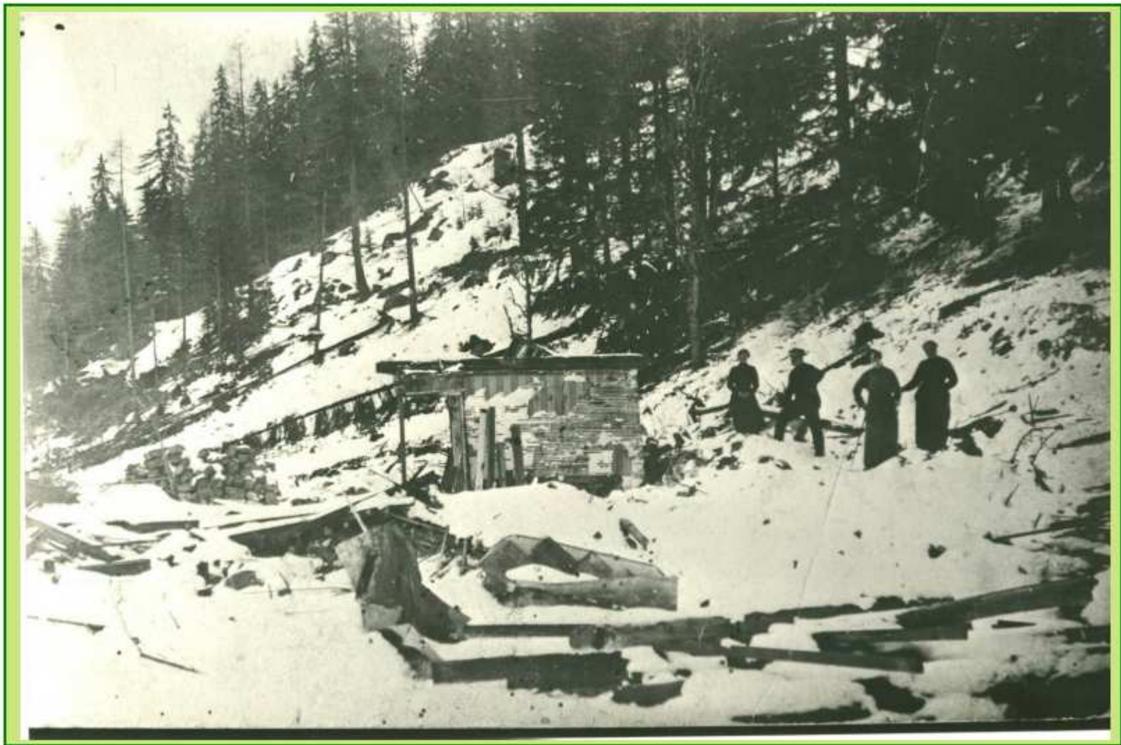
Maison Boyer ; avalanche de la Combe à Bocheray ; 1923
