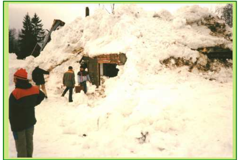
Un chalet est détruit (cliché RTM)
