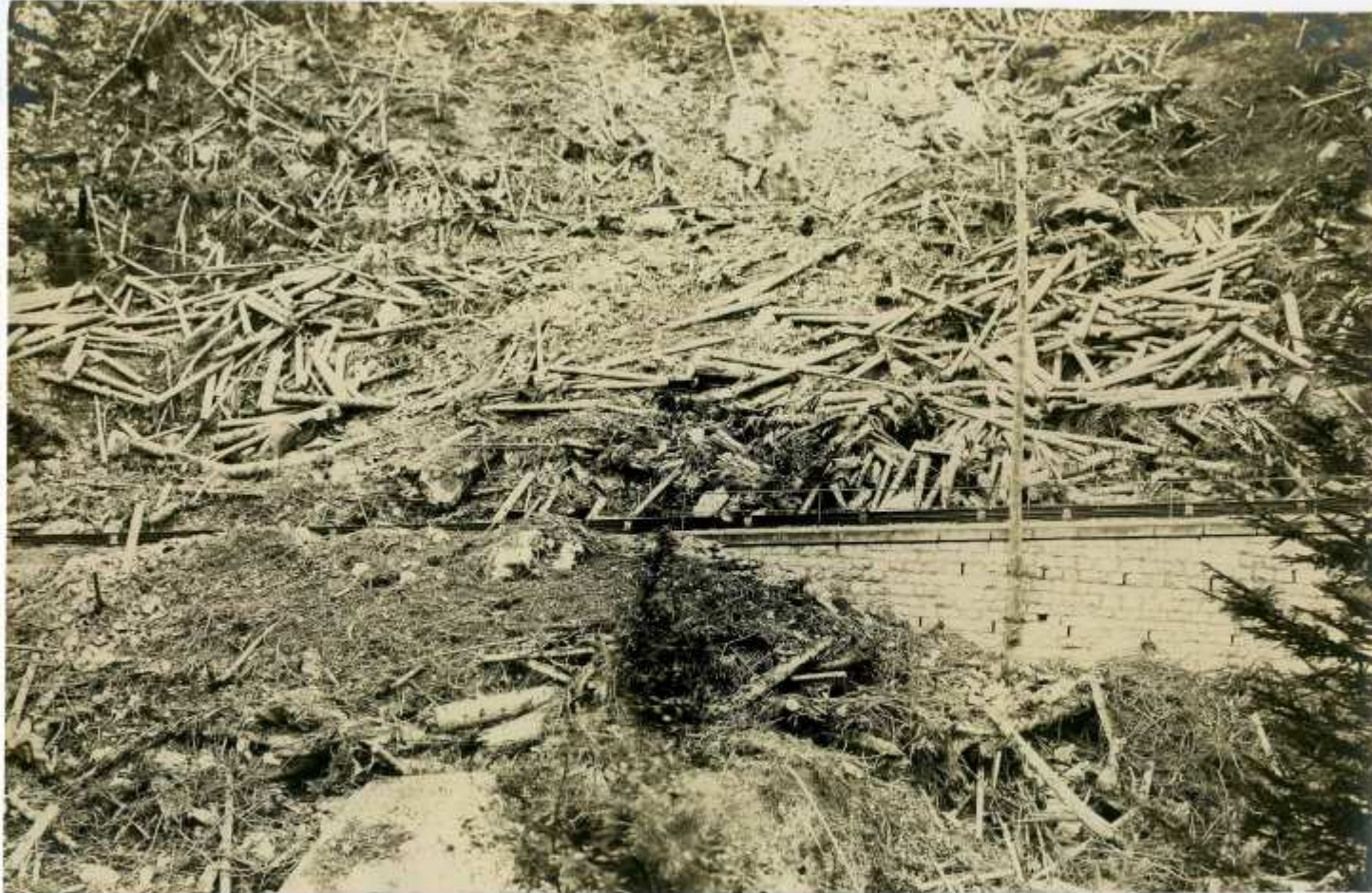
24 juillet 1924 Vue de détail des bois transportés par l'avalanche du 29 décembre 1923 (Ravin de Chauffriaz près de la voie ferrée Chamonix-Argentière)
