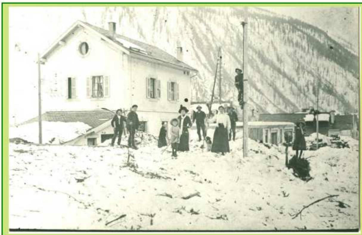
Avalanche de la Combe à Bocheray en 1923 ; L'usine électrique - La coopérative.
