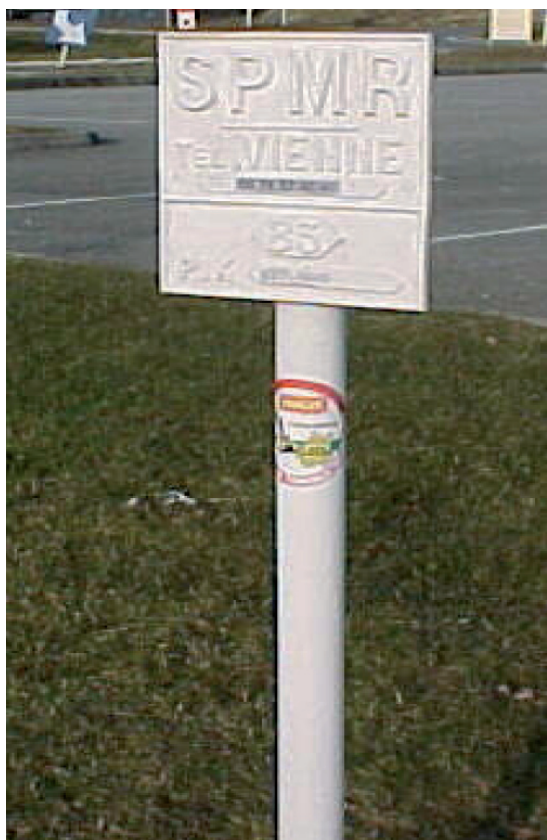
Signalisation de la présence de canalisations (gazoducs et oléoducs)
