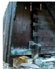
assemblage à queue d'aronde
