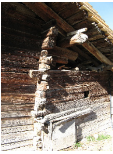
détails d'assemblage des madriers
