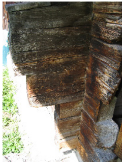
détails d'assemblage des madriers
